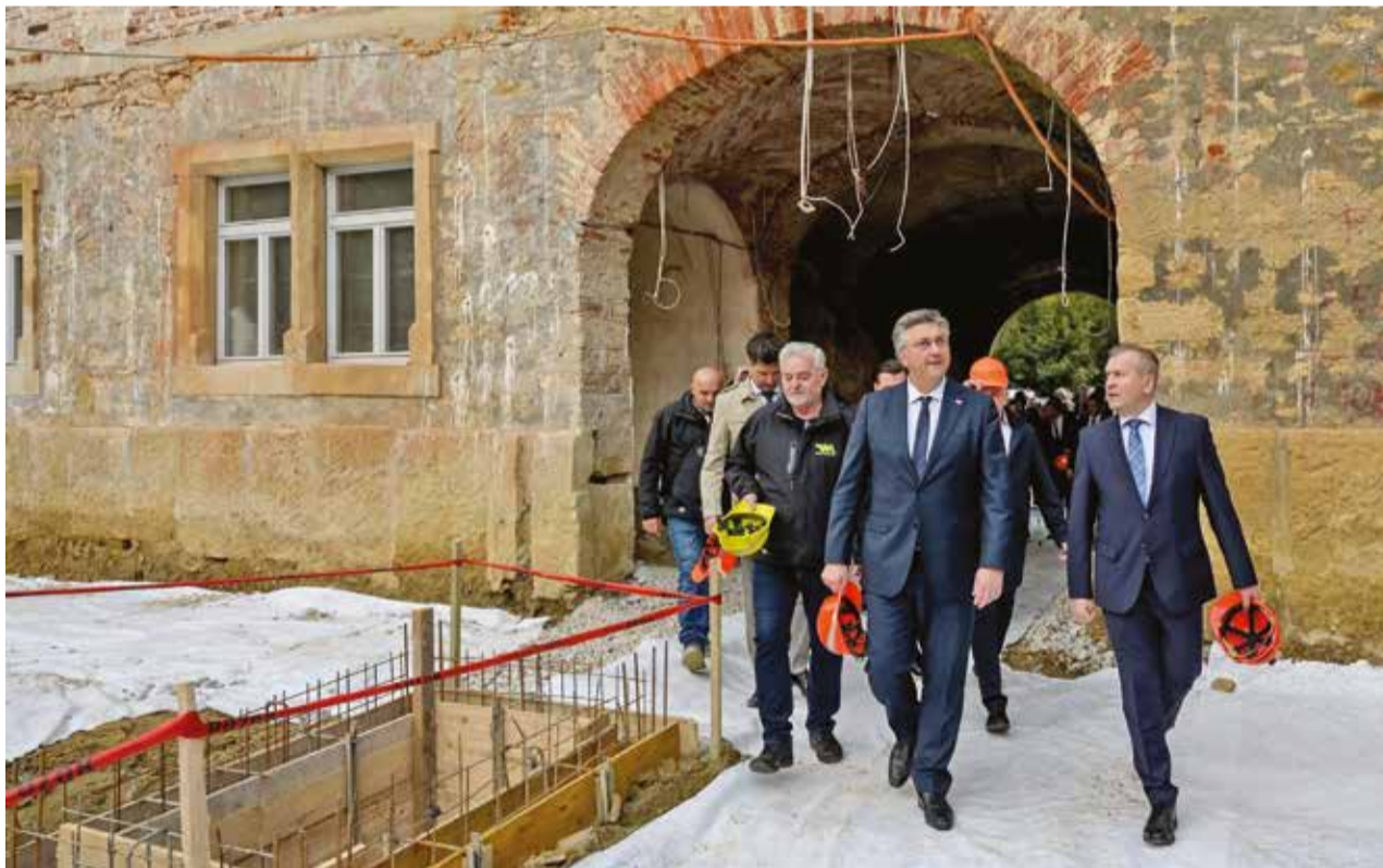
Gradilište dvorca Opeka je, uz župana Stričaka, obišao i predsjednik Vlade RH Andrej Plenković
